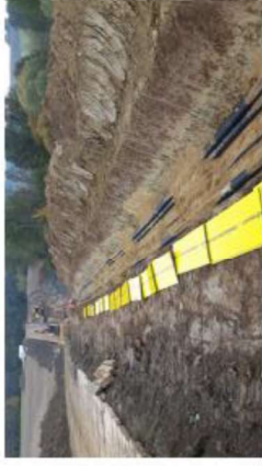
Abb. 1: Wiederverwendung von Bodenaushub beim Ver von Erdkabeln. Hier wurde der Oberboden (links bildlich vom Unterboden (rechts) getrennt und ir schluss wieder lagenweise eingebaut.
