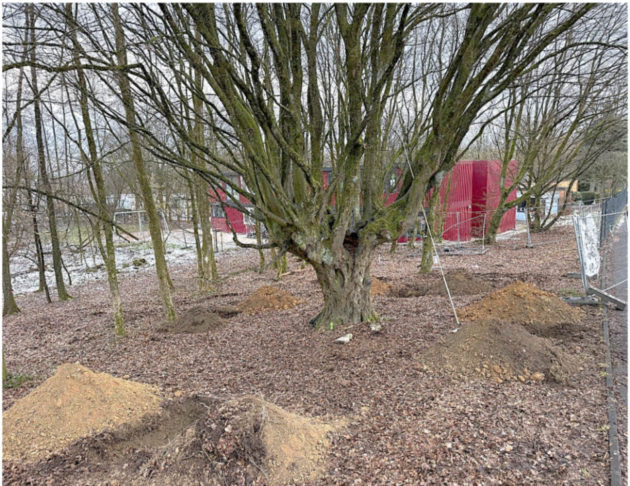
Abbildung 17: Vier Wurzelsuchgräben im Norden, Westen, Osten und Süden
