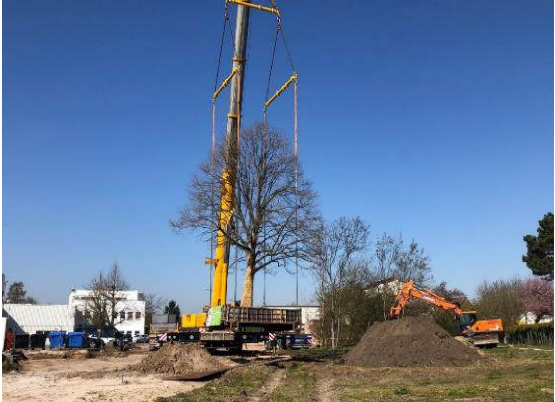
Abbildung 23: Ein Teleskopkran hebt einen Größtbaum mit Ballen
